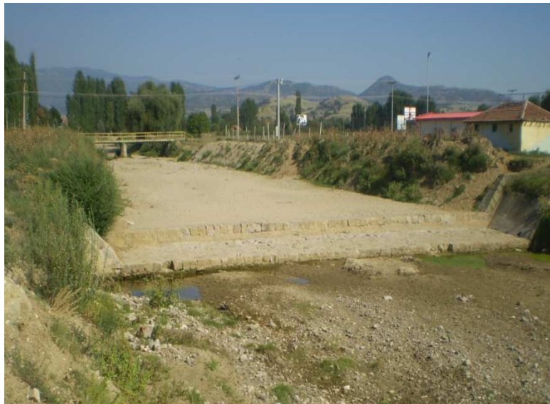
Слика бр.2 Постоечки каскадни прагови на речно корито на р.Козјачка, с.Карбинци
